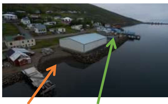
Sjósetningaraðstaðan og félagsaðstaðan hægra megin
